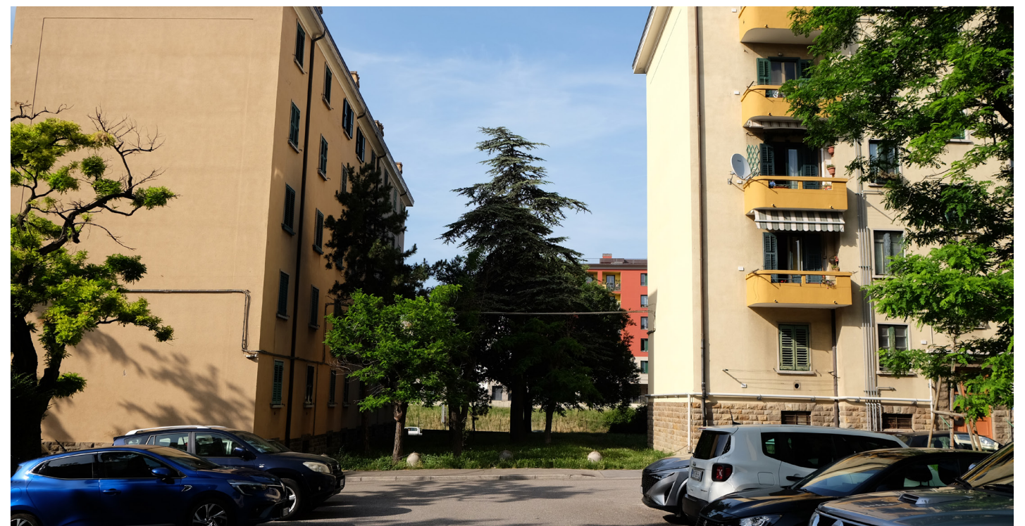
06 - Vista da Piazzale Giarizzole 3
