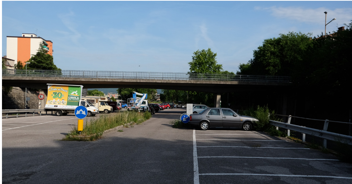
03 - Vista dall'interno di Parcheggio Pubblico Giarizzole
