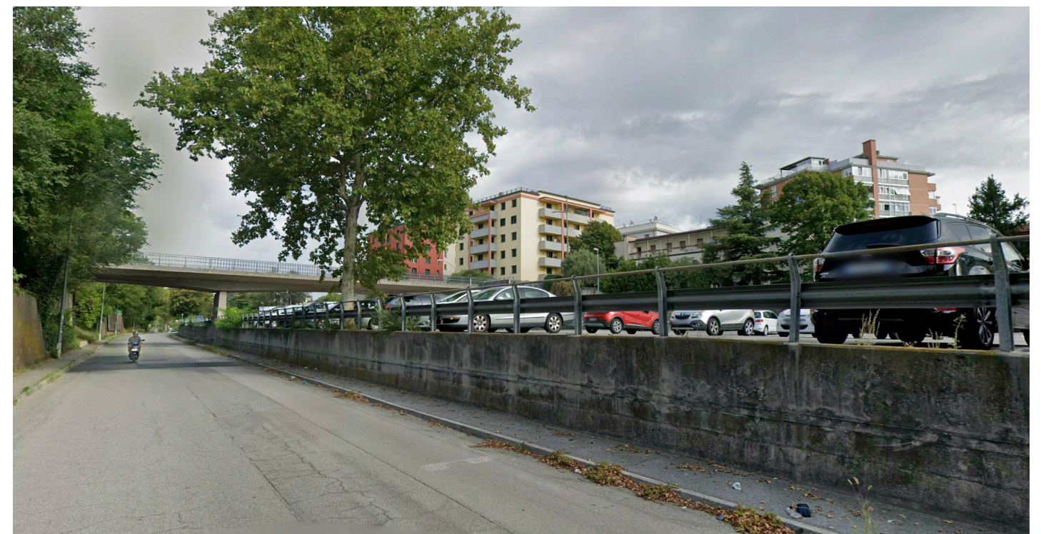
02 - Vista da via Mafalda di Savoia
