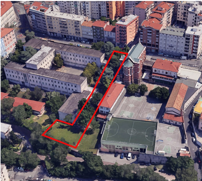
Sopra, la porzione del pendio della Bergamas interessato dal nuovo accesso alla Cottur.
